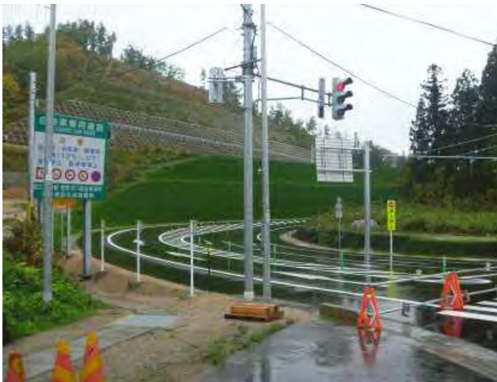
《 開通前の米沢八幡原IC 》
